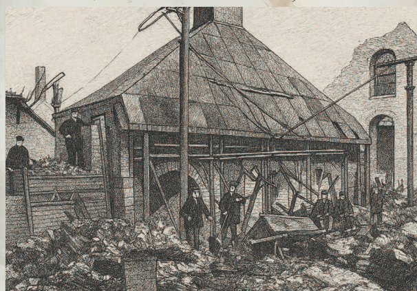
Фабрика после пожара, 1886 год
